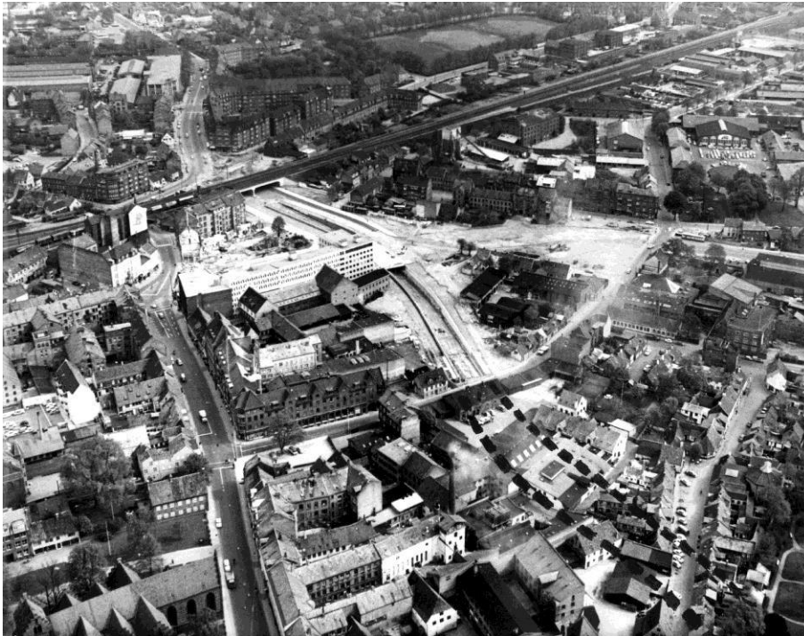
Thomas B. Thriges Gade under anlægsfasen
